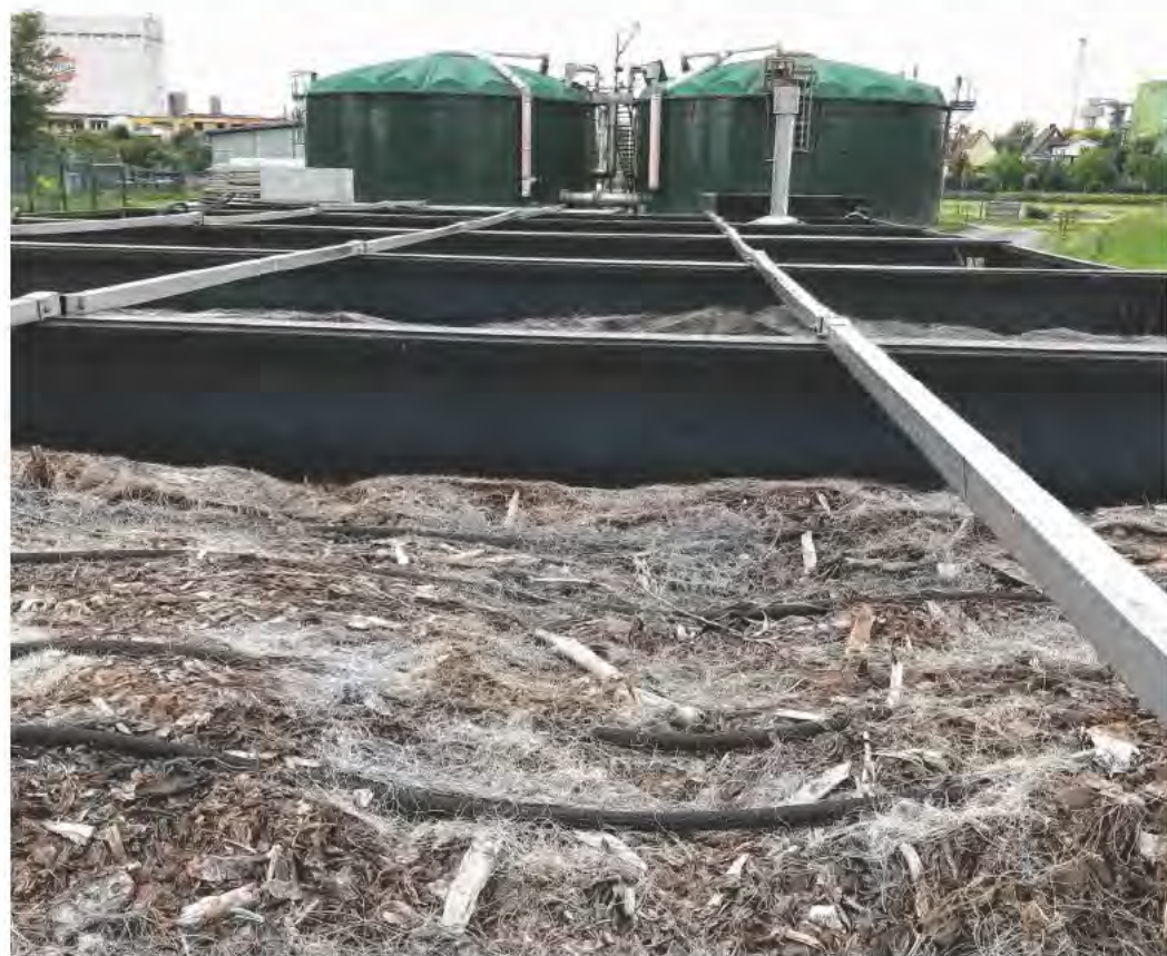
Die Biofilter auf der Stavenhagener Kläranlage sind damit überfordert, die starken Gerüche herauszufiltern. Eine Anlage zur Abluftbehandlung soll den Gestank eindämmen. FOTO: ECKHARD KRUSE
