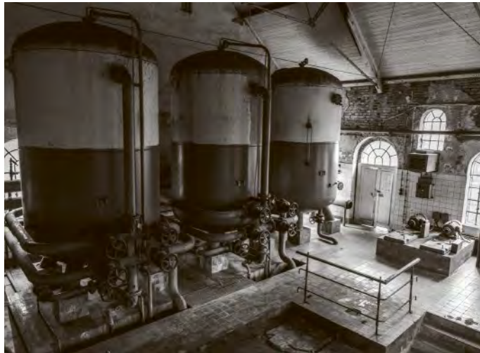
So hat es einst im alten Wasserwerk in Malchin ausgesehen, das 1903 in Betrieb gegangen und in den 1980er Jahren stillgelegt worden war. Die Kessel sind inzwischen ausgebaut.
