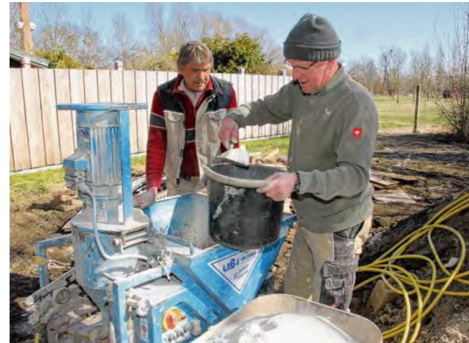
Ingo Radloff (rechts) und Henri Pagels von der Borrentiner Firma Hicke bedienen die Putzmaschine. Im Anbau des alten Wasserwerkes bringen sie Dämmputz an.
