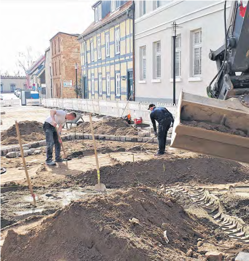
Noch wenige Tage, dann ist der erste Abschnitt der Petersilienstraße fertiggestellt. Foto: Thomas Koch
